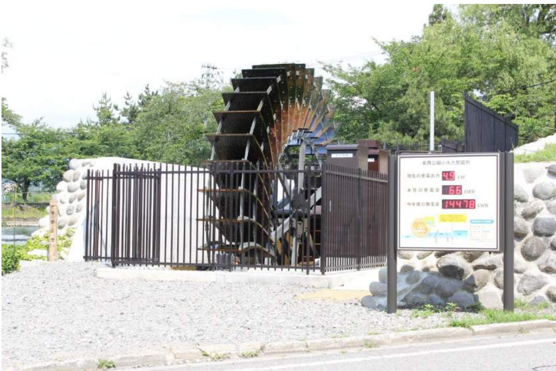
小水力発電施設（上滝地内）
